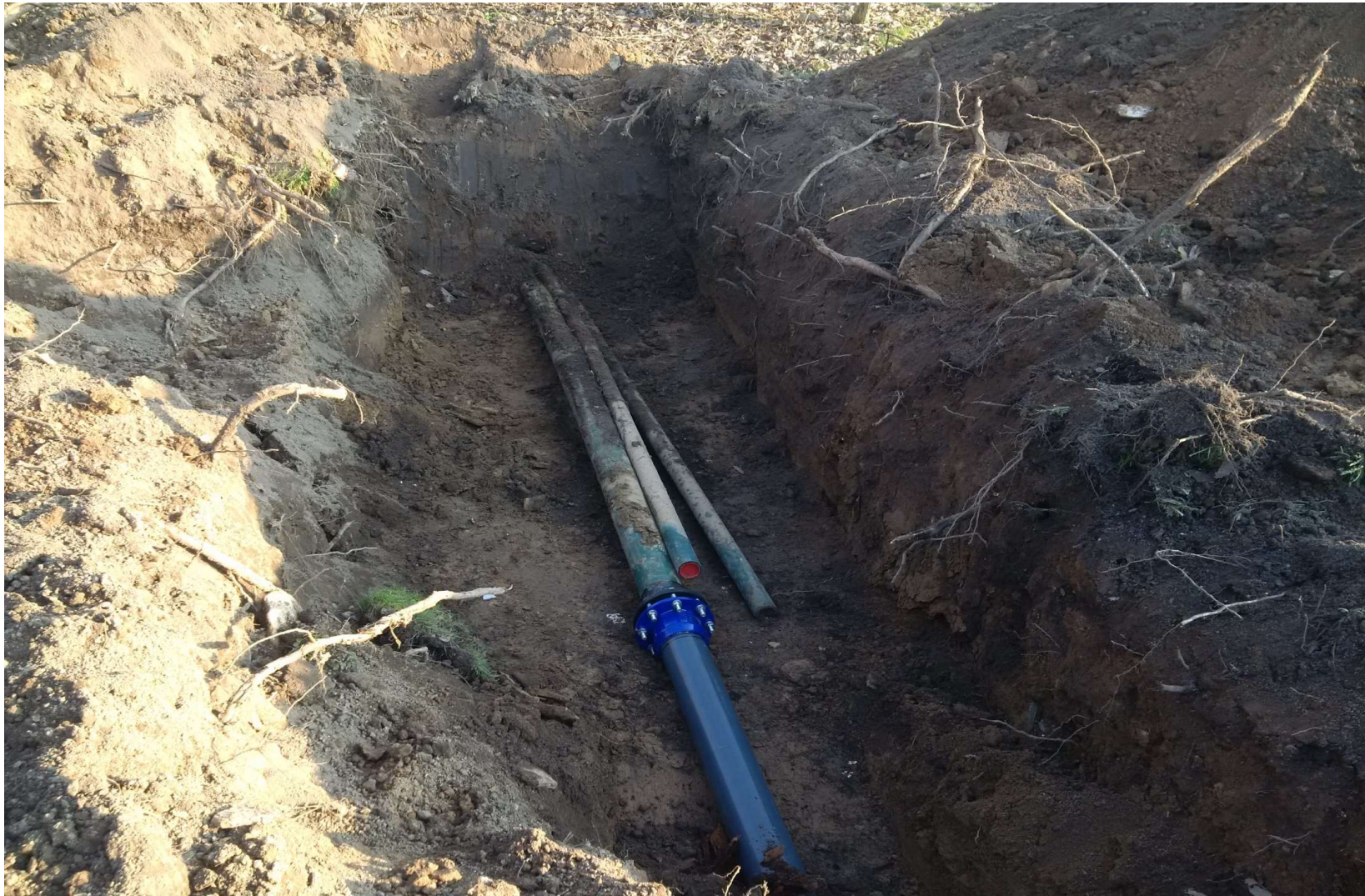
Bewässerung in Südniedersachsen
